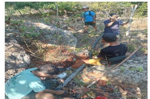
Gambar 3. Tim melakukan patroli ke wae waso hingga lengko nggurung sekaligus instalasi ulang pipa air yang terpasang
