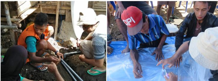
Pemasangan pipa aliran gas dari *digester* ke penampungan dan ke kompor
