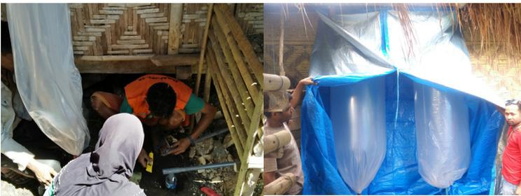
(Gambar Kiri) Penyambungan Pipa Saluran dan (Gambar Kanan) Tangki Penampung Gas
