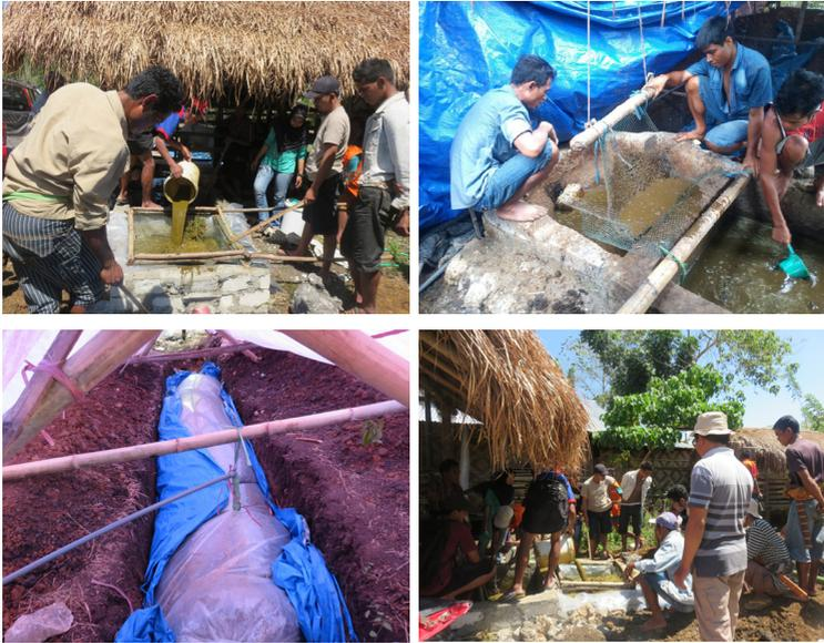
Pengisian Bahan Biogas campuran kotoran sapi dan air ke Digester/Reaktor
